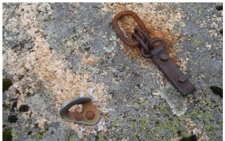
Spit de 6 mm como reequipamiento/refuerzo del rapel. Esto ya cumplió su función. Foto Archivo FMM.
